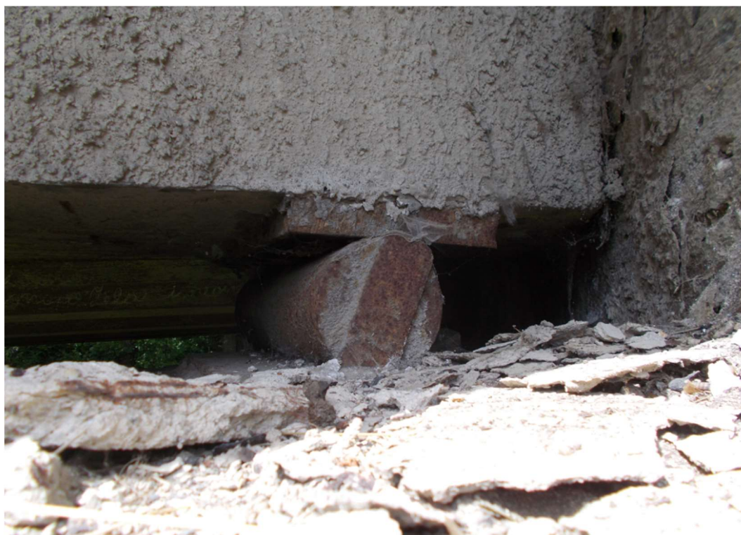
Obrázok 7– Detail uloženie NK a zablokovania posunu
