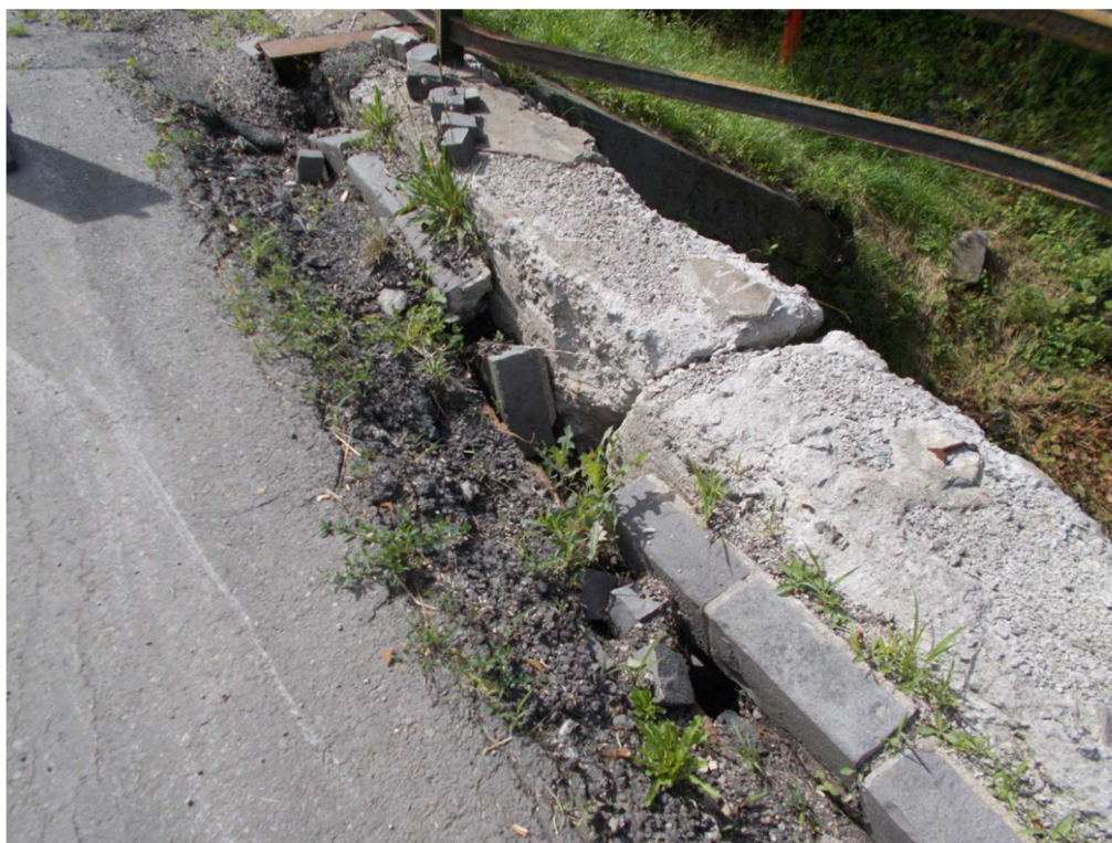
Obrázok 13 – Zdegradovaná rímsa a odvodnenie
