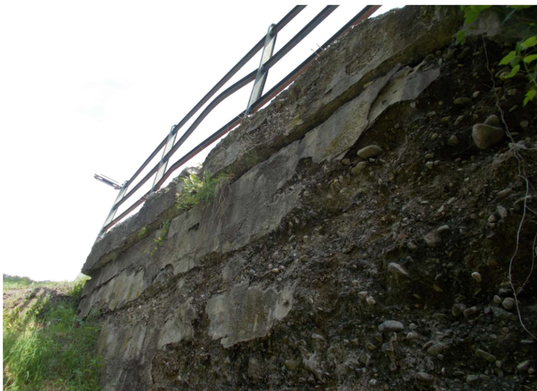
Obrázok 11 – Detail poškodeného krídla
