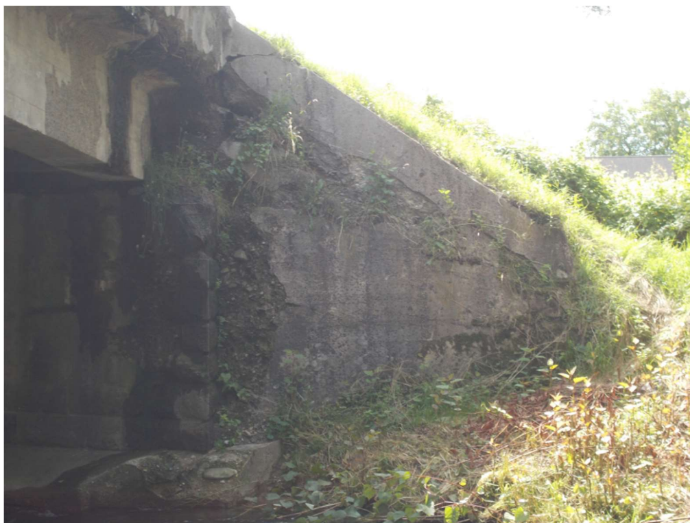
Obrázok 12 – Detail poškodeného krídla
