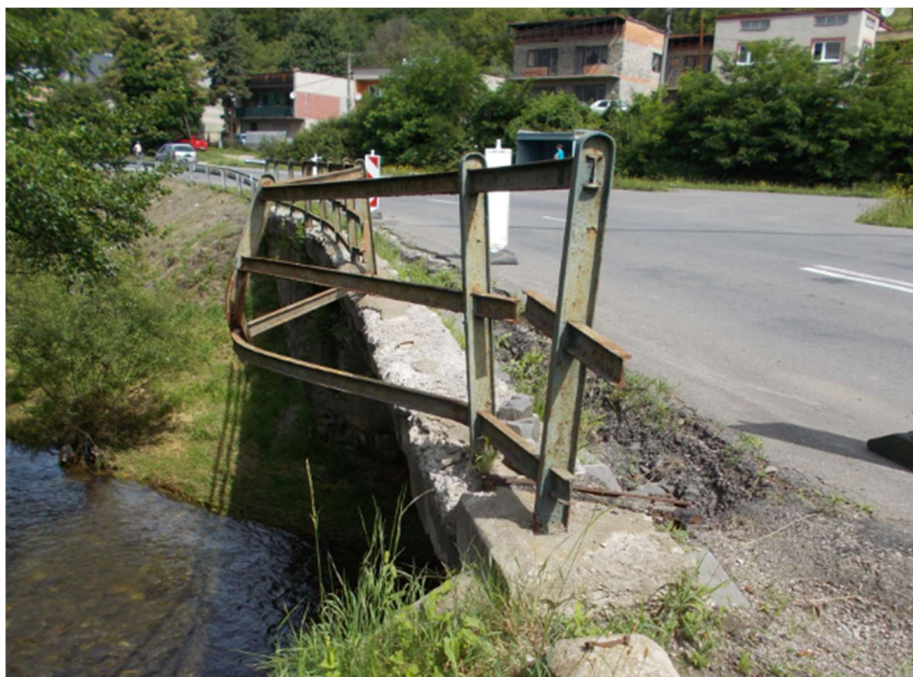
Obrázok 10 – Detail poškodeného zábradlia
