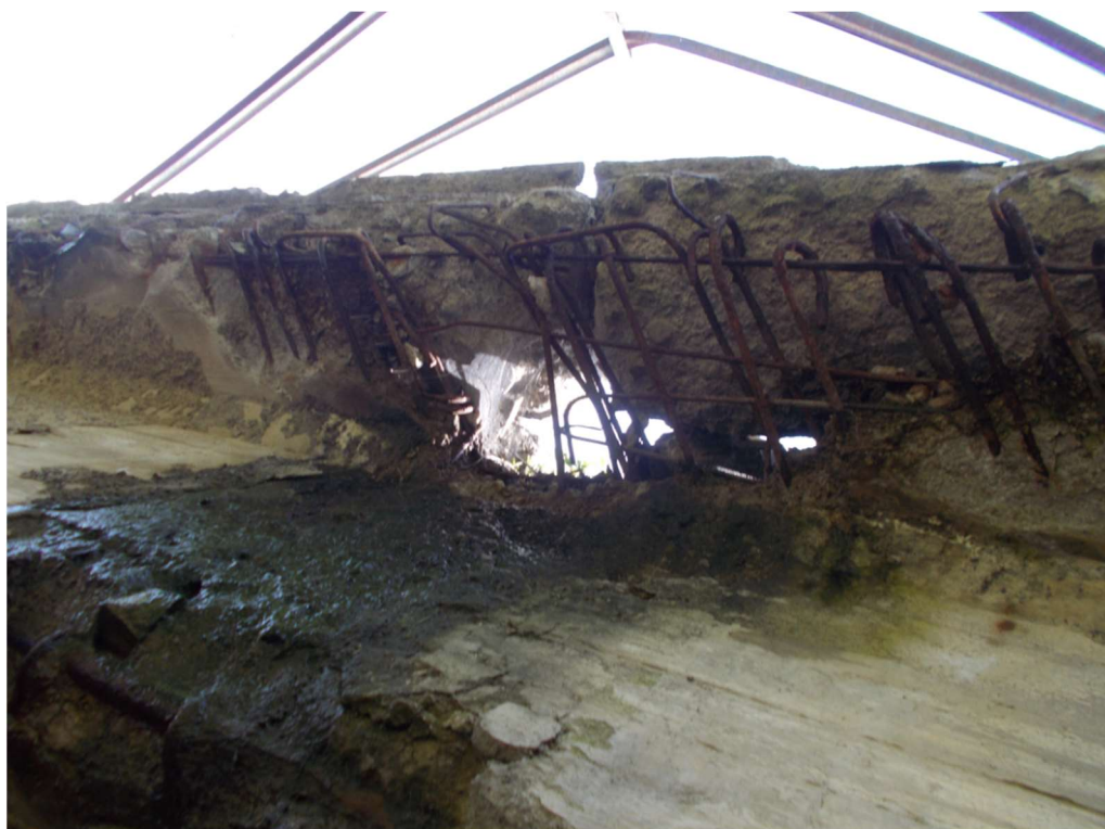
Obrázok 8 – Detail lokálnej totálnej degradácie
