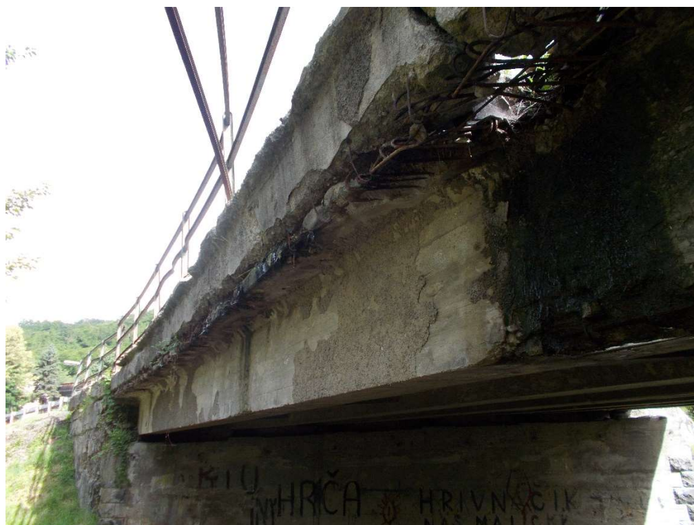
Obrázok 9 – Detail zdegradovanej konzoly a rímsy
