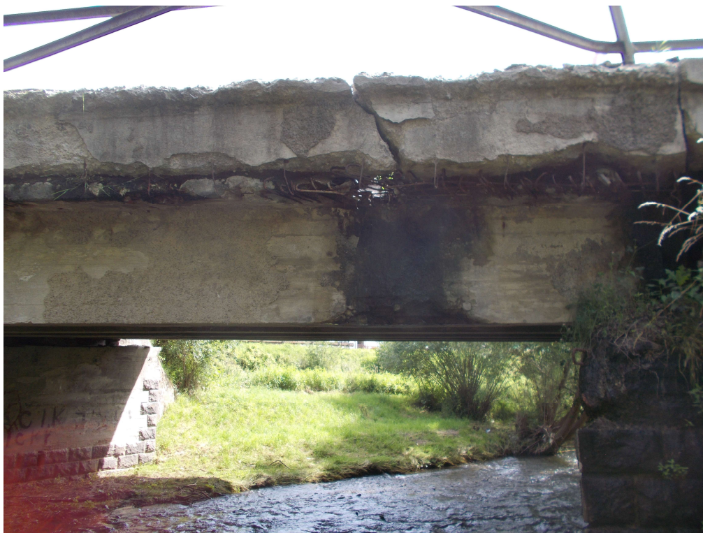
Obrázok 5–Detail nosnej konštrukcie – zatekanie z poškodeného odvodnenia + zdegradovaná konzola
